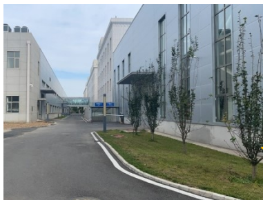
西侧：厂区内道路
