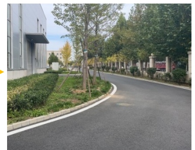
东侧：厂区内道路
