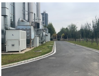
南侧：厂区内道路
